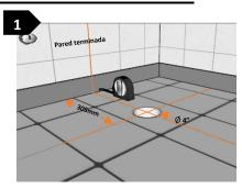
Verifique la distancia que hay entre la pared y el centro del tubo, está distancia debe ser de 305mm (12 pulg.) según normativa y el diámetro de la tubería debe ser de 4 pulg PVC.
